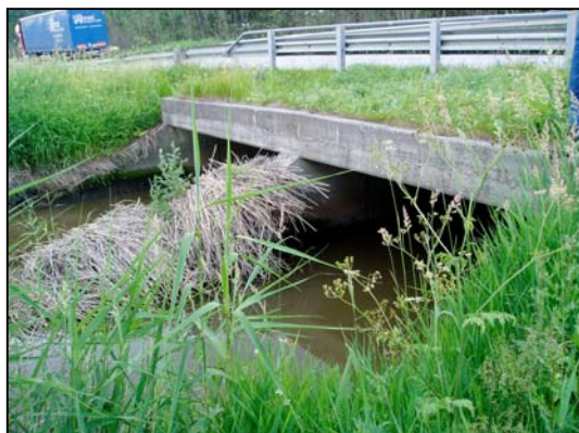
Kulverten ved Skjebergbekken
